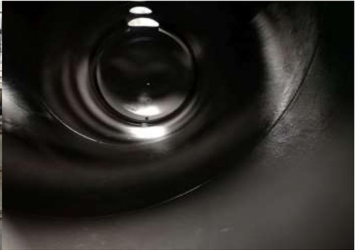
Resimac抗化学品涂层用于与大部分工业化学品的接触及完全浸泡工况。
