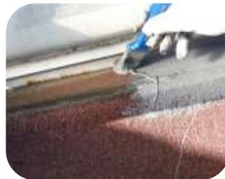
泄露的矿物毡屋顶接缝使用551 快速防水涂层密封
