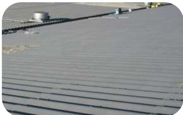
金属屋顶在涂覆506底胶后，涂覆550防水薄膜涂层。
