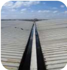
600 米的玻璃钢屋顶排水渠使用551快速防水涂层密封修复。
