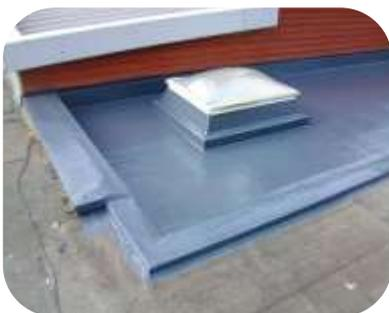
工厂屋顶使用557&558防水系统进行密封防水。
