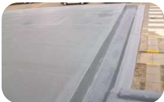
工厂屋顶使用552防水底层及550防水薄膜涂层作为面层。
