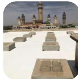
3000m<sup>2</sup> 混凝土平屋顶涂覆2层550防水薄膜涂层。
