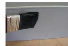
待第一层固化后，在20°C下约为30分钟。涂覆第2层膜厚为400微米涂层。
